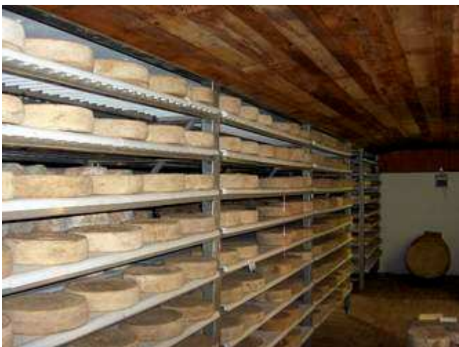
Soffitti in legno (sempre per garantire un buon isolamento) recuperati da strutture antiche demolite
