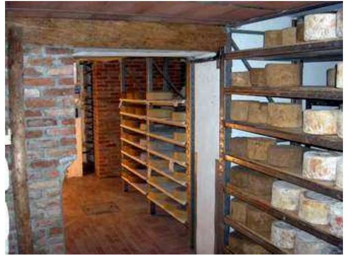
Murature e travi di legno riemerse durante il restauro delle Cantine Guffanti di Arona. Il pavimento è in cotto.
