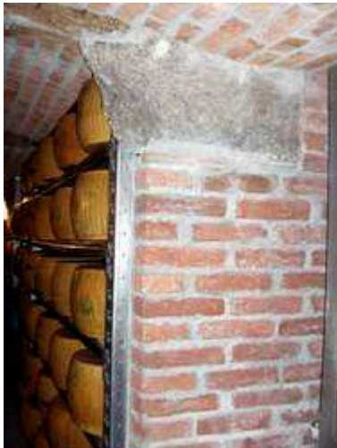
Strutture portanti in sasso vivo
