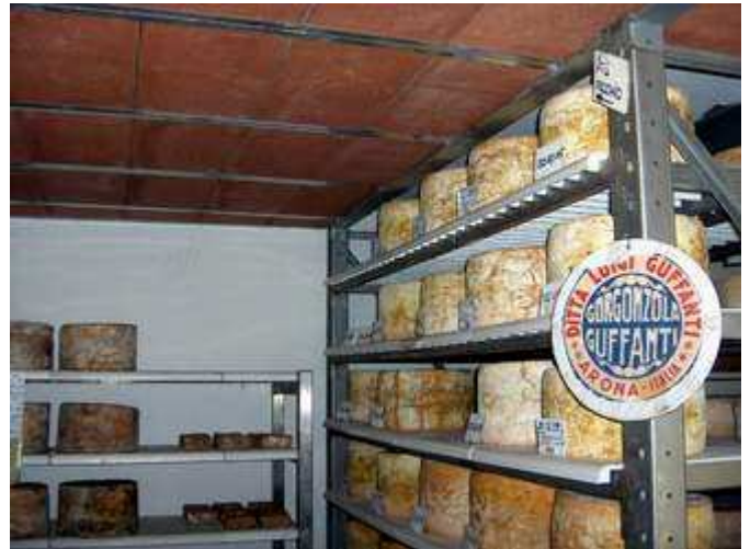
Soffitto di materiale naturale (tavelle di cotto) per garantire un migliore isolamento dalla superficie
